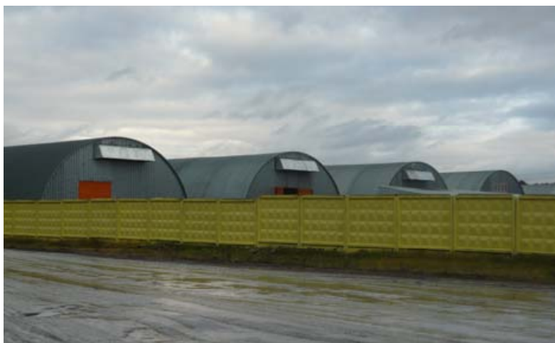
Рис. 13.20. Общий вид комплекса хранилищ.
