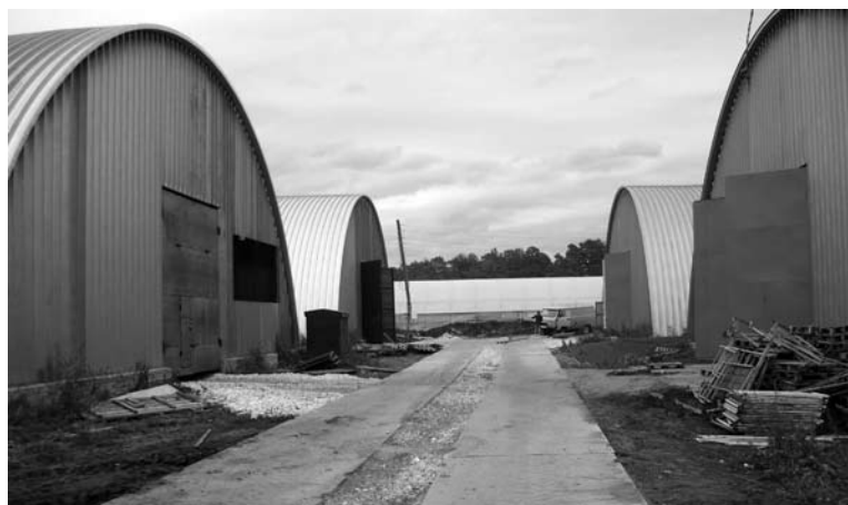
Рис. 13.6. Комплекс арочных металлических хранилищ (ЗАО «Озёры» Московская обл.)
